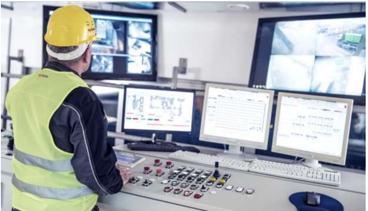
Рис. Внешний вид SCADA
